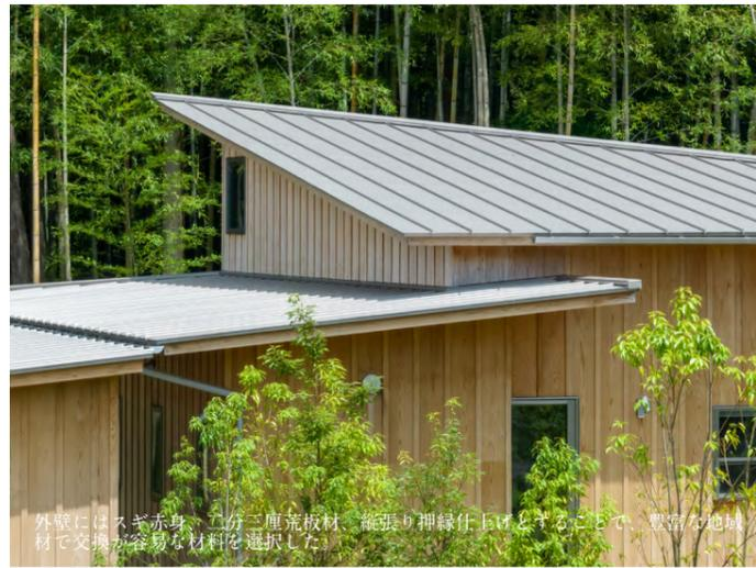
外壁にはスギ赤身、二層三厘荒板材、縦張り押縁仕上げとすることで、豊富な地域材で交換が容易な材料を選定した。
