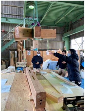
↑張弦梁の検討において意匠+構造設計者、施工者で入念に検討した。写真のモックアップは施工者が自主的に作成したものの。
