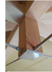
←モックアップ製作で気づいた束材の欠損めり込みを考慮し、束材には堅木であるケヤキ材を選定した。
